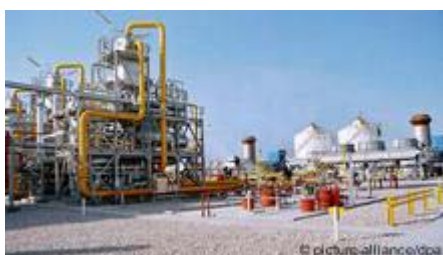
Erdgasförderung in Turkmenistan
