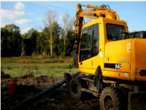
Будівництво водогонів у Недригайлівському районі Сумської області — завдяки проекту ЄС/ПРООН
