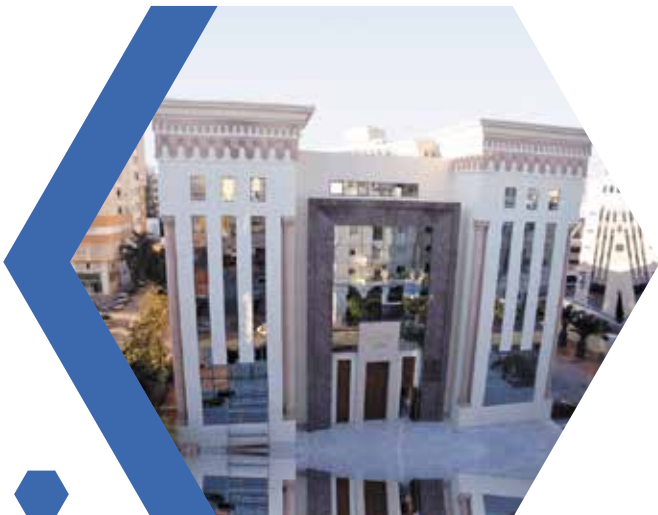
Ci-contre Vue en façade du TPI Sfax (Travaux de second œuvre achevés)
