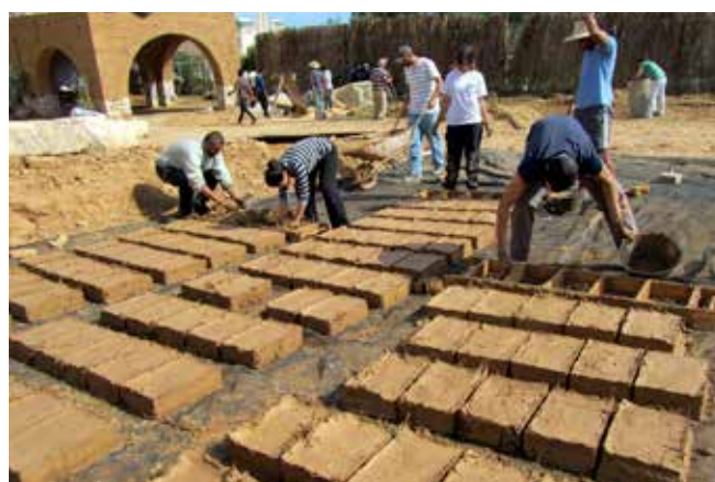
Eco-construction : fabrication des briques de terre à Sidi Amor
