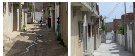
Réhabilitation du quartier Sidi Hcine à Tunis - avant / après
