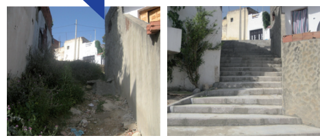
Réhabilitation du quartier El Khadra à Béja - avant / après
