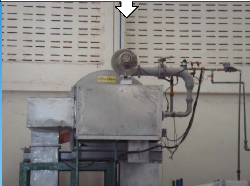
ตำแหน่งติดตั้งหัวพ่นไฟ
