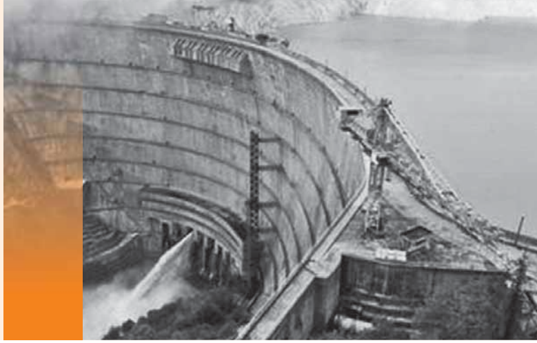
Centrale hydroélectrique Géorgie © CE
