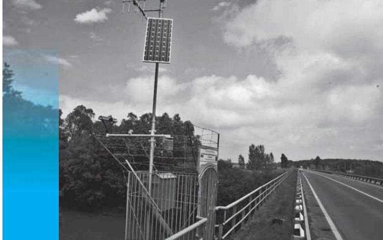
Amélioration d'un système de gestion des crues Ukraine © CE
