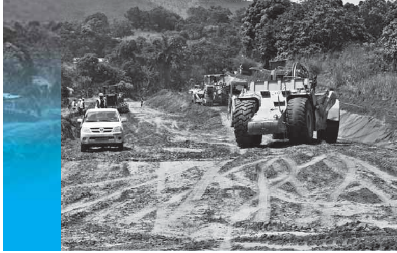
Projet d'amélioration des infrastructures routières Congo © CÉ/Claudio Bacigalupi
