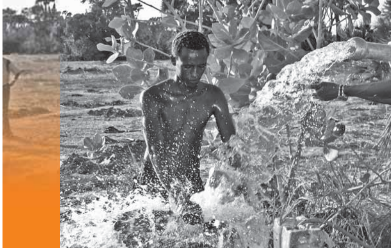
Essais d'un nouveau puits Érythré © CE/Stéphane Halgand
