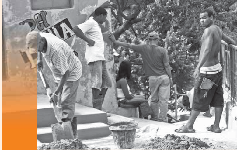
Construction de routes d'évacuation plus sûres République Dominicaine © CE/Susana Perez Diaz
