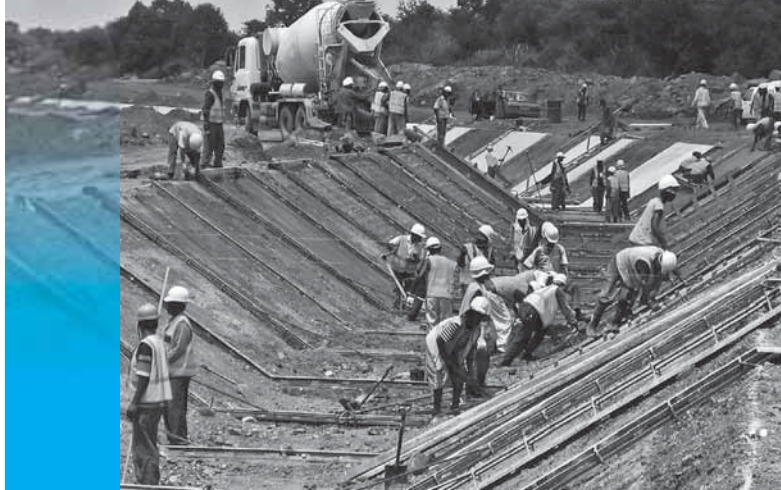
Construction d'une canalisation d'amenée Swaziland © CE/Peter Beck Christiansen
