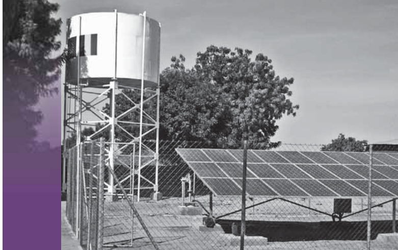
Point d'eau solaire (AEP Solaire) à Gonori Tchad © CE
