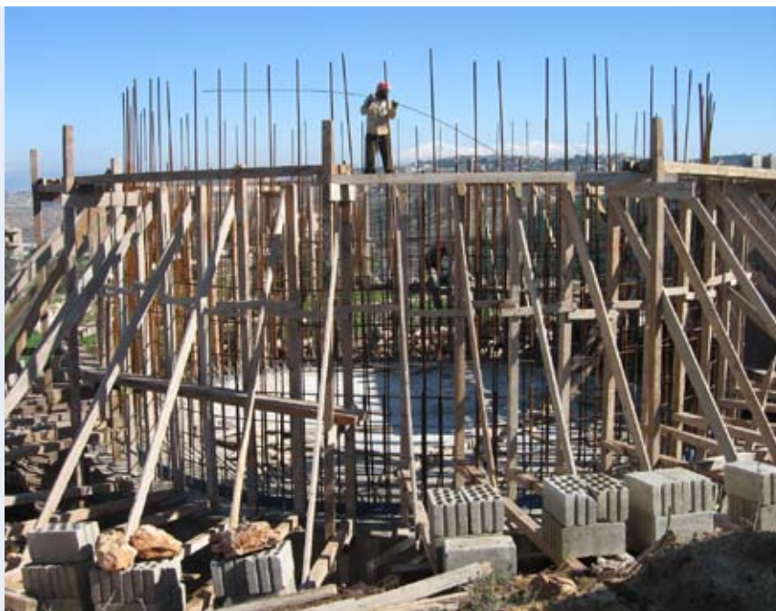
Construction du réservoir d'eau à Kafra
