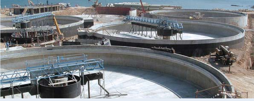
محطة معالجة مياه الصرف الصحي في طرابلس (الممولة من البنك الأوروبي للاستثمار).
