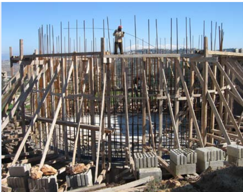
Construction du réservoir d'eau à Kafra
