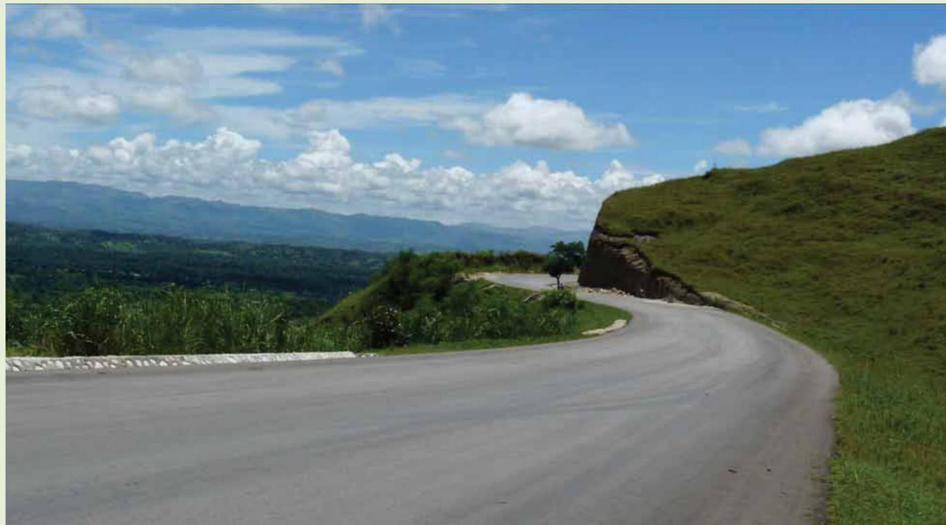
Tronçon de la route nationale numéro 3 (RN3) en cours d'achèvement entre les villes de Mirebalais et Hinche. La RN3 en cours de réalisation par l'Union européenne relie la capitale Port-au-Prince et la deuxième ville du pays Cap haïtien. Photo: Alexandre Polack
