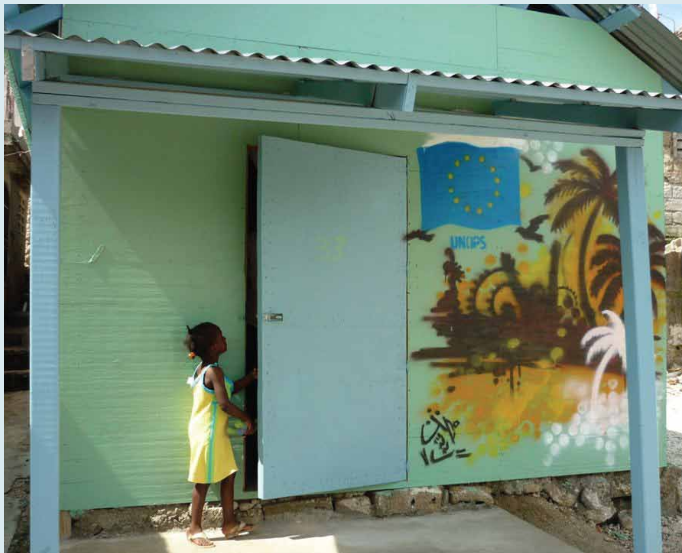
Construction de logements provisoires à Port-au-Prince. Photo: François Duboc
