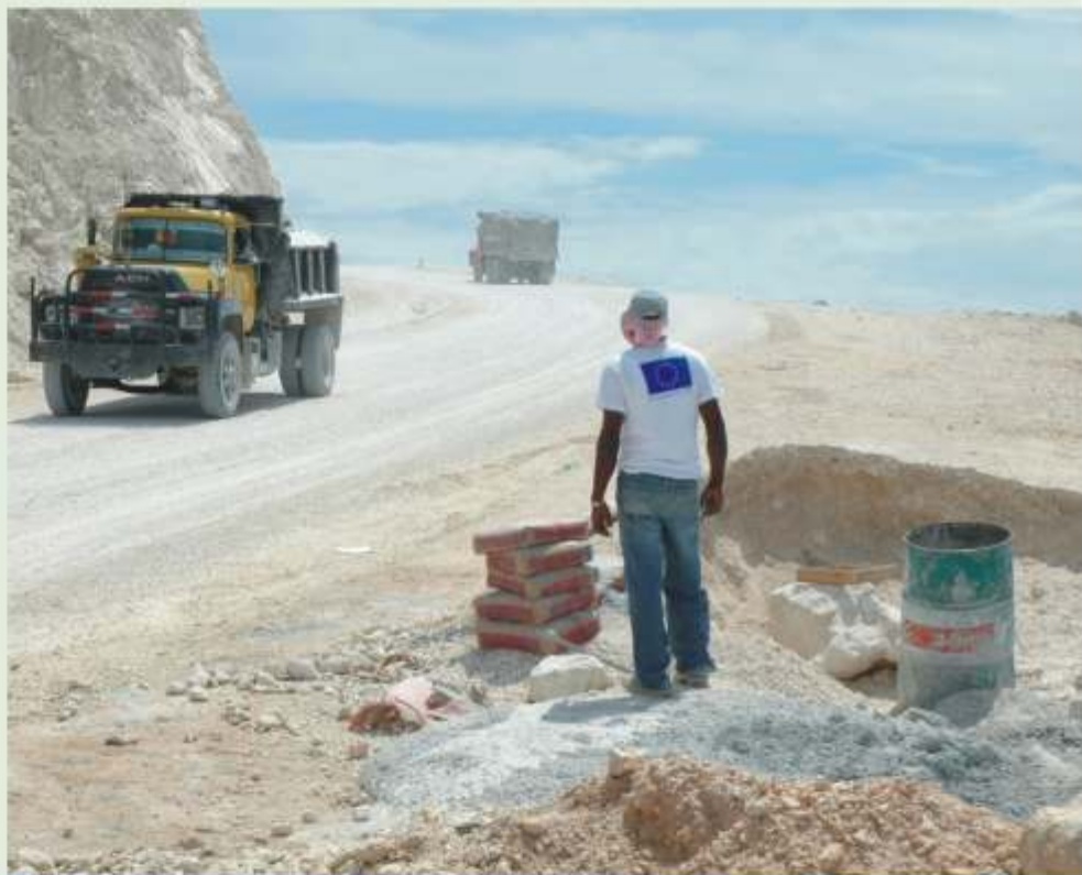
Route nationale 3 Port au Prince - Mirebalais en cours d'exécution
