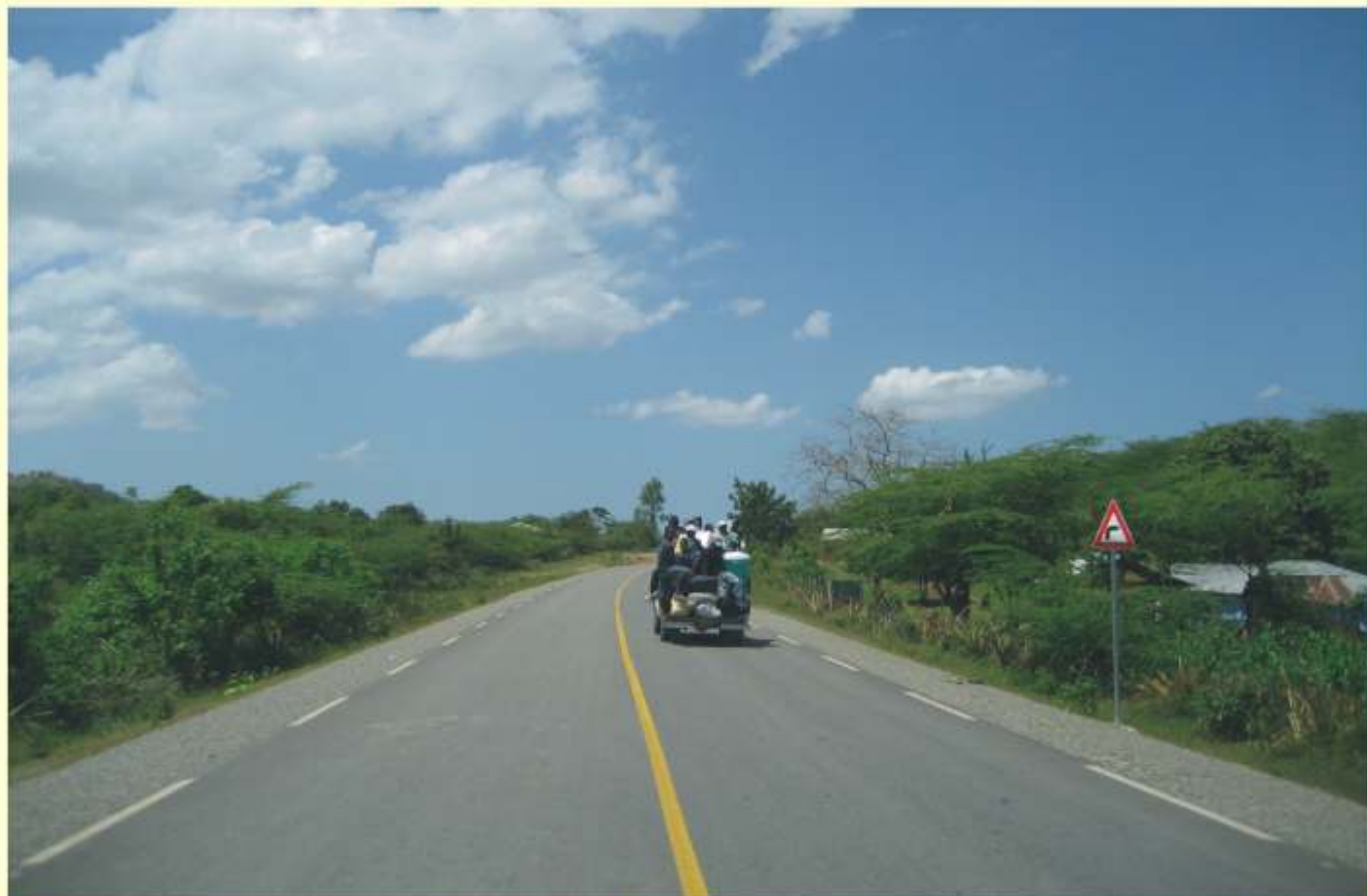
Route nationale 6 Cap haïtien - Ouanaminthe terminée en décembre 2008
