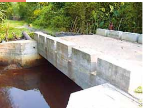
Pont construit sur Lunkuni dans Bagata
