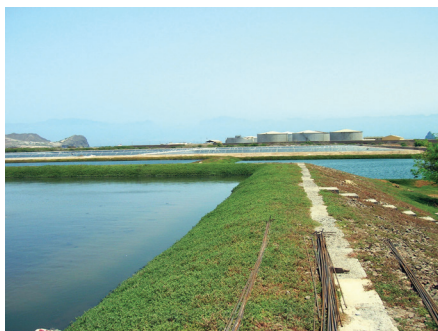
Estação de Águas Residuais, Mindelo, S.Vicente
