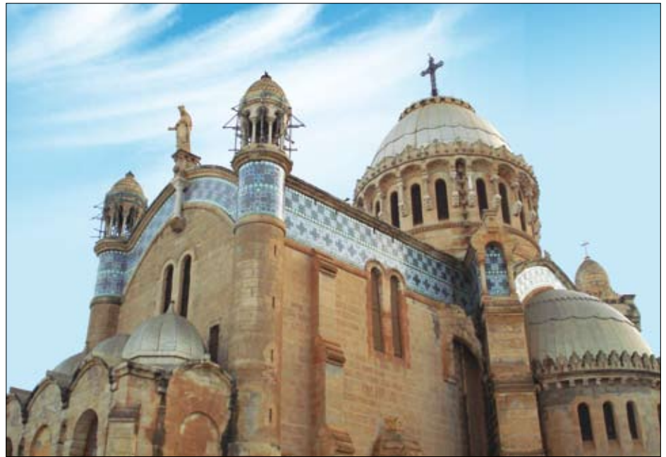
Le chantier de la Basilique de Notre Dame d'Afrique.
